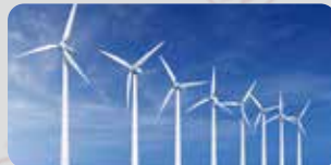
风力发电设备
